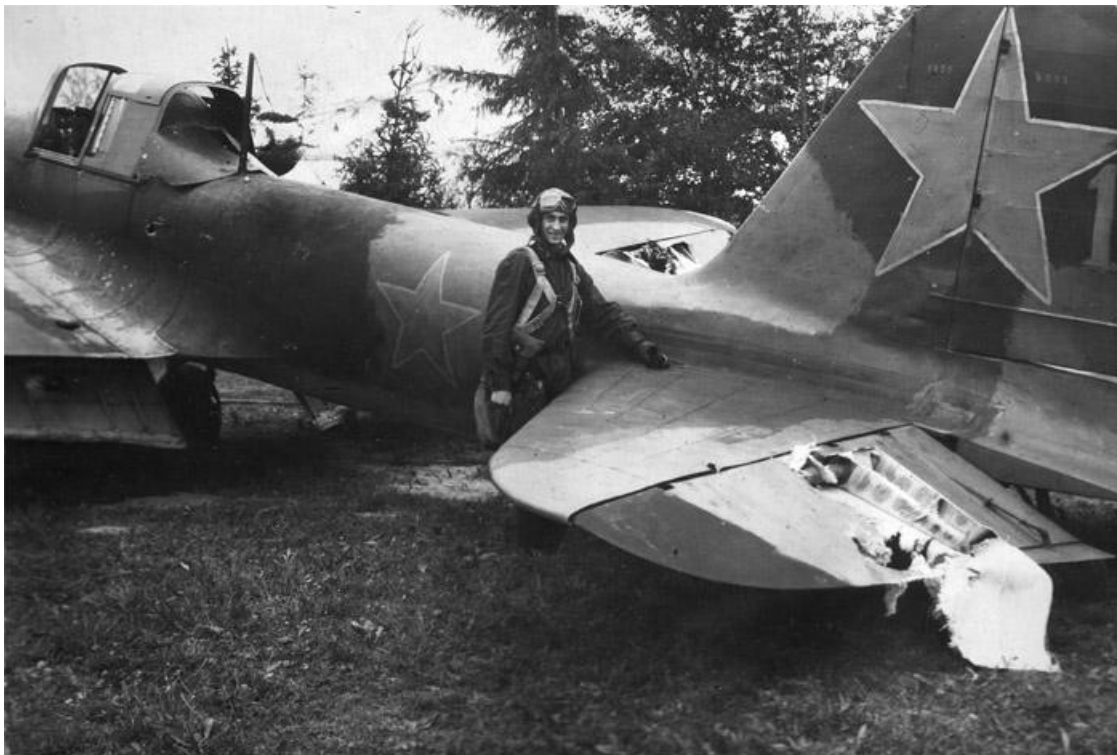
3 боевой вылет, повреждения Ил-2 5-ю 37 мм снарядами. Разбит руль глубины, разрушен правый лонжерон, разбит правый элерон, вырвана правая пушка, сорваны задние бронелисты с кабины, мелкие повреждения крыльев и фюзеляжа.
