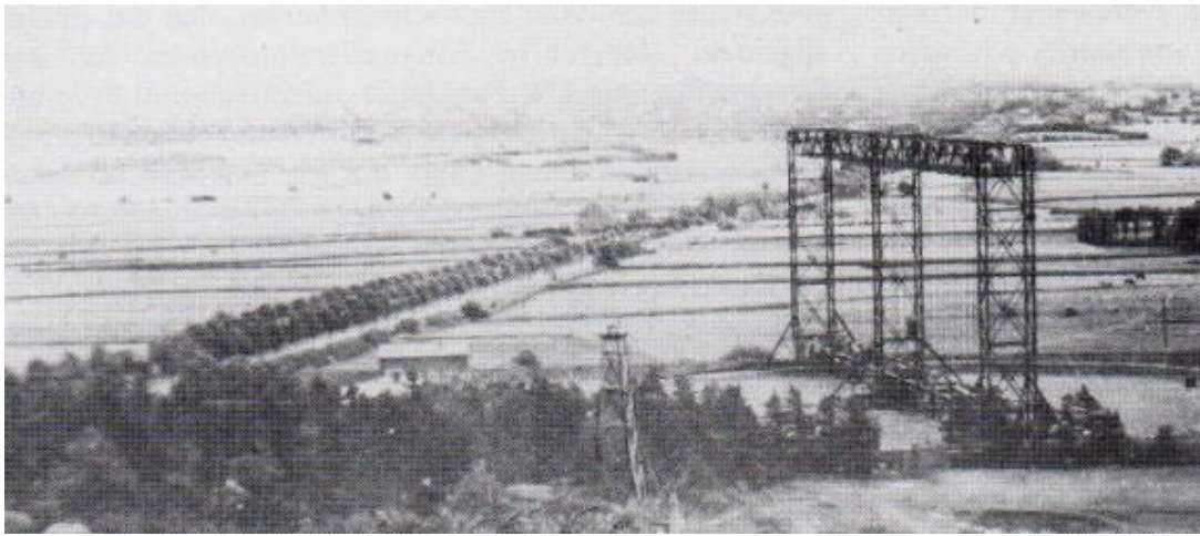
Большой (90x40 м) антенный массив «Кникебайн» (FuSAn 721) в Клеве, Германия (граница с Голландией). Хорошо видна круговая железнодорожная колея для установки антенны в нужное положение.
